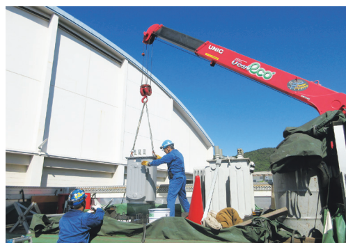
搬出作業の様子
