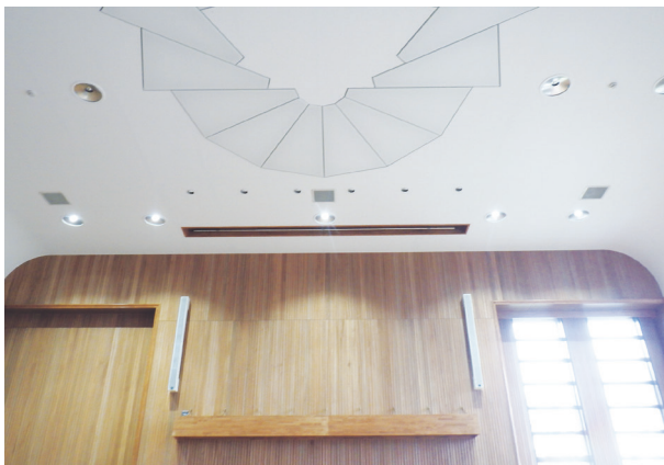
鹿田会館・講堂 (LED照明)
