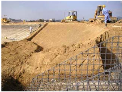
ため池の補修工事
