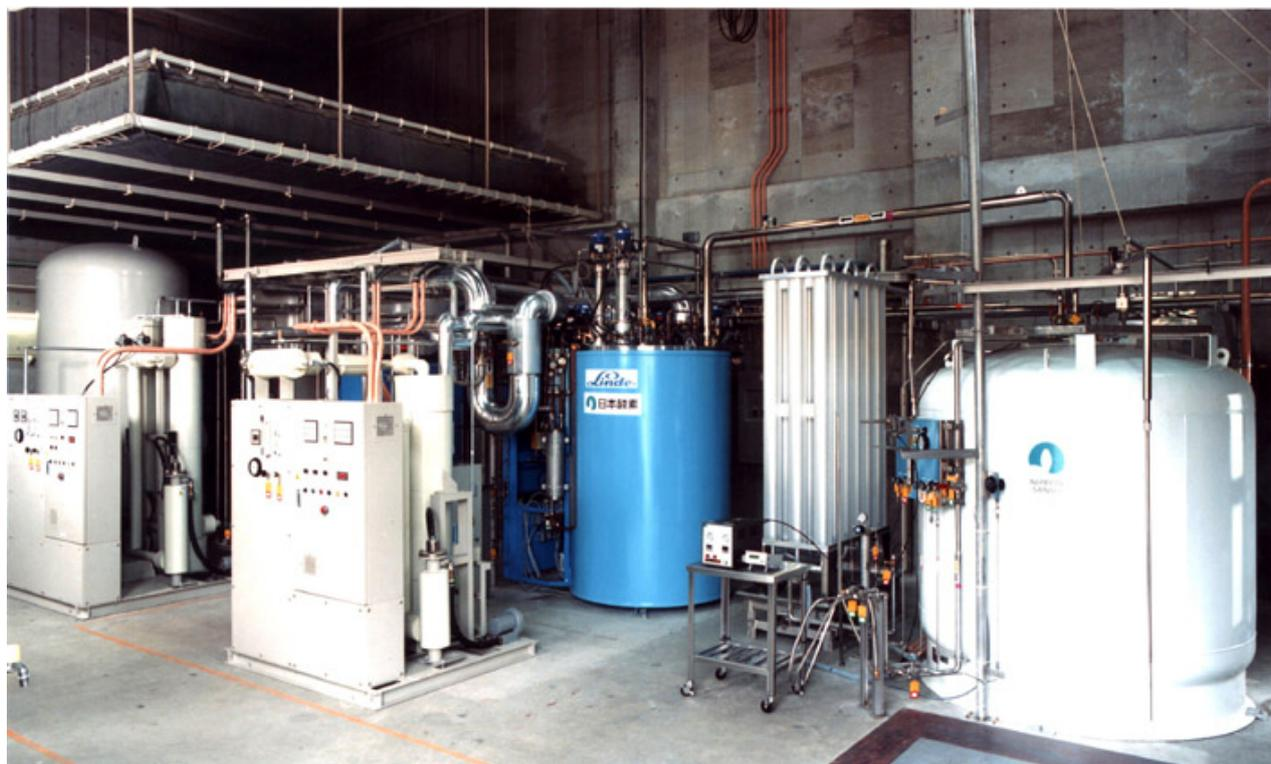
広島大学のヘリウム液化装置。（岡山大学に設置されるものと類似の機種）中四国の国立大学でヘリウム液化装置を所有する大学は広島大・岡山大のみである。
