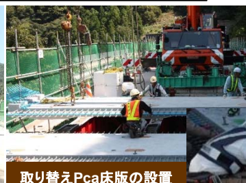
取り替えPca床版の設置
