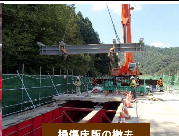
損傷床版の撤去
