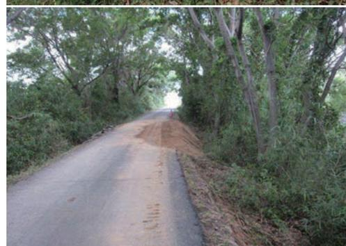
越流による小崩落の箇所
