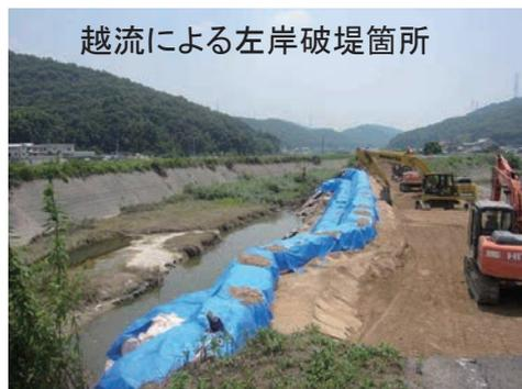
越流による左岸破堤箇所
