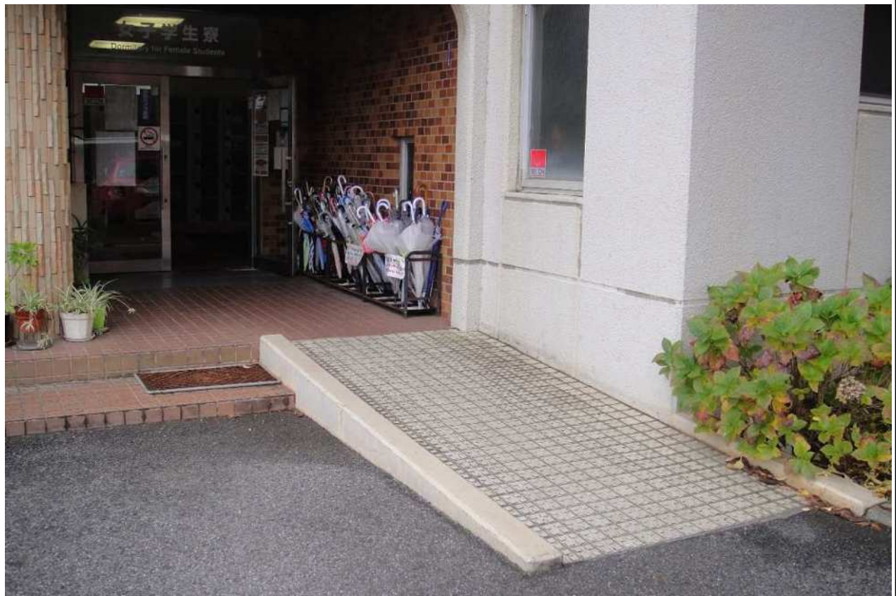
3 玄関(スロープ)
