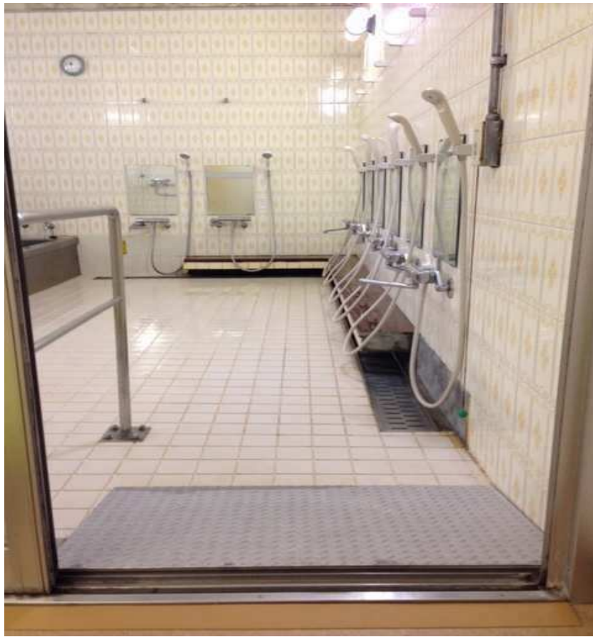
19 浴室(スロープ)
