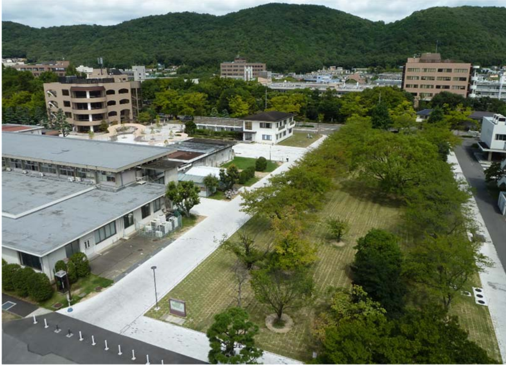
資料6 整備後の一般教育棟西側エリア
