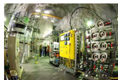
(図3) 神岡地下施設に設置した200トンガドリニウム水チェレンコフ検出器(EGADS)
