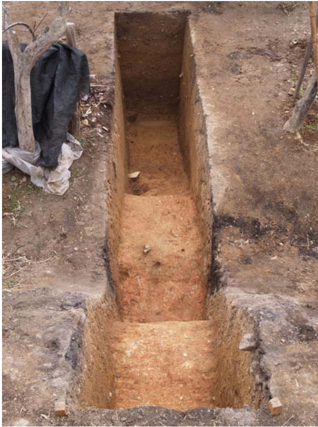
a くびれ北1トレンチ (墳丘側から)
