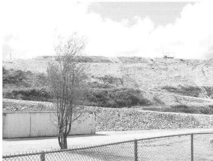
写真 3-1-11 グアムにおける最終処分場
