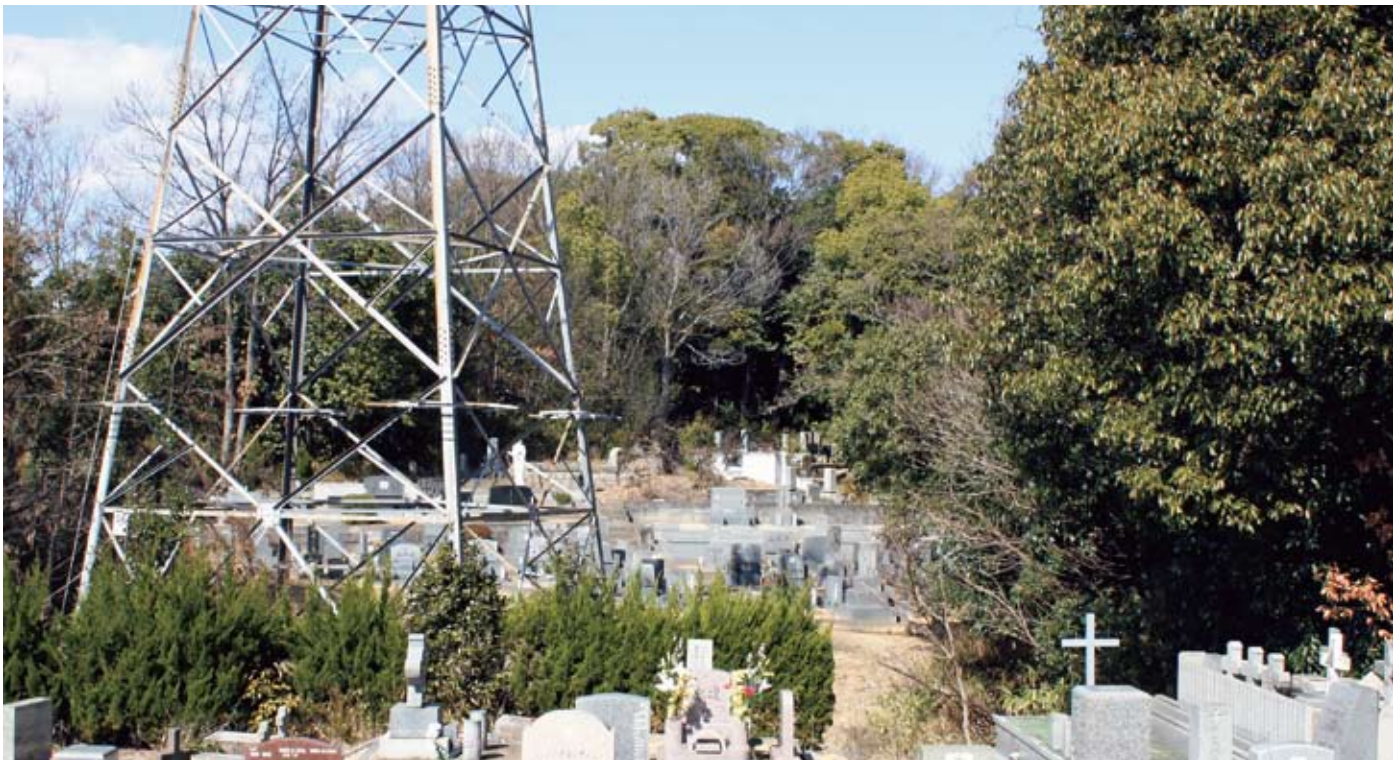
2 北側より古墳をのぞむ 鉄塔と墓地の奥の箇所が古墳の位置
