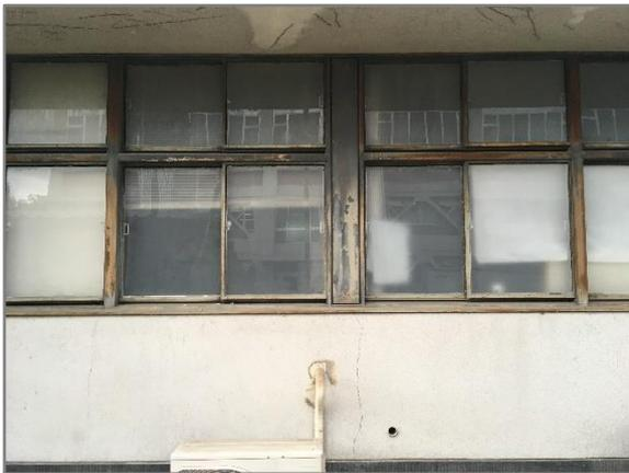
外壁面のひび割れ、及び窓枠の腐食と開閉不良
