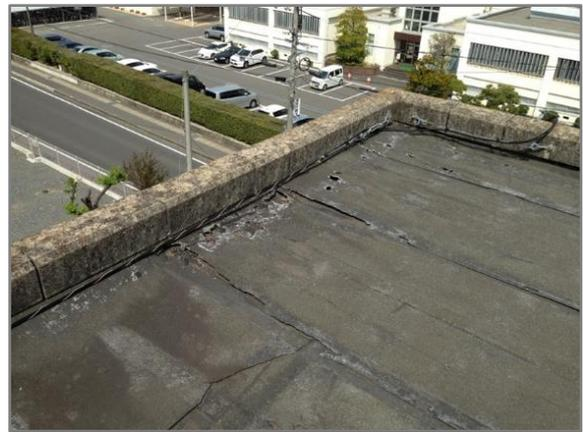
広範囲にひび割れ、変質 (摩耗)、排水不良が見られる
