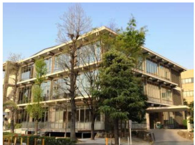
鹿田分館・外観
