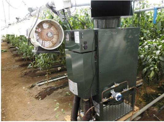
図II - 3 CO<sub>2</sub>施用機と送風機 (ﾄﾞｰﾏﾝ圃場)
