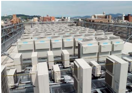
総合診療棟 高効率空調室外機
