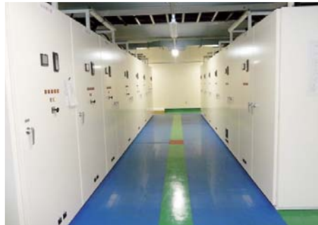
総合診療棟 電気室
