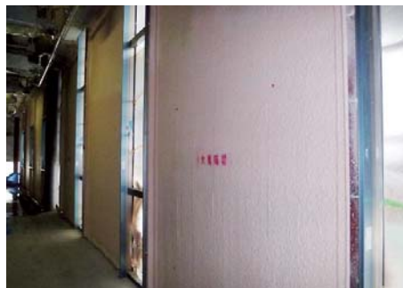
総合診療棟 断熱材施工状況
