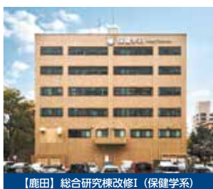
【鹿田】総合研究棟改修I（保健学系）
