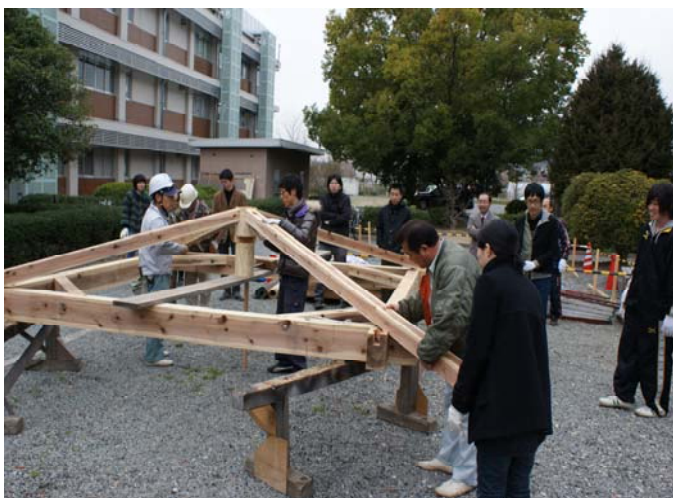
東屋組立作業（3月9日）
