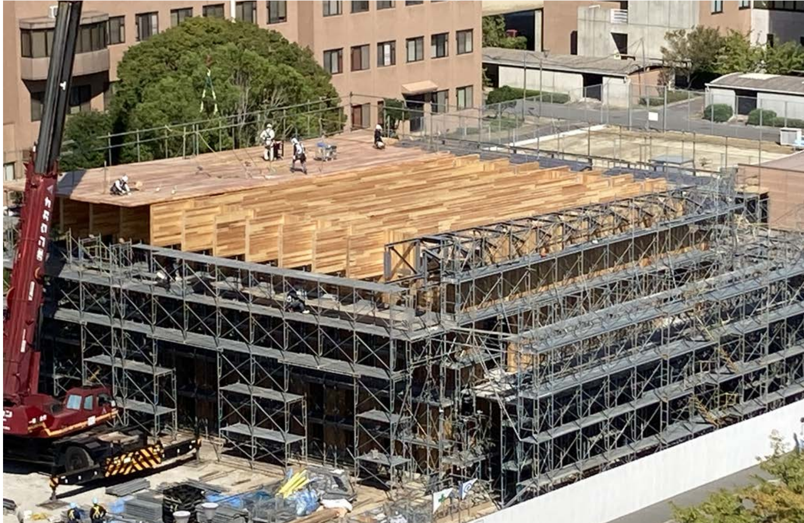
岡山大学 共育共創commons建設状況
