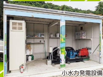
小水力発電所の建屋と導水管
