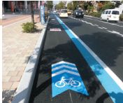
② 岡山駅東口周辺
