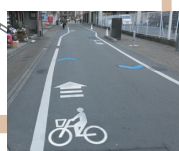
④ 岡山駅東口周辺細街路
