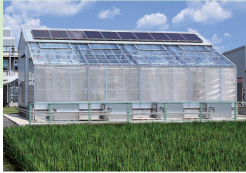
▲省エネ型組換え植物育成装置 組換え植物などを人工光や自然光で育成する装置で、太陽光パネルで発電が可能。東日本大震災復興プロジェクトでは、オオムギの早期育成などに活用している。
