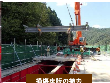
損傷床版の撤去
