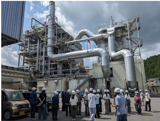
真庭バイオマス発電所 見学
