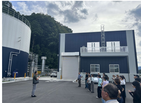
真庭市くらしの循環センター 見学
