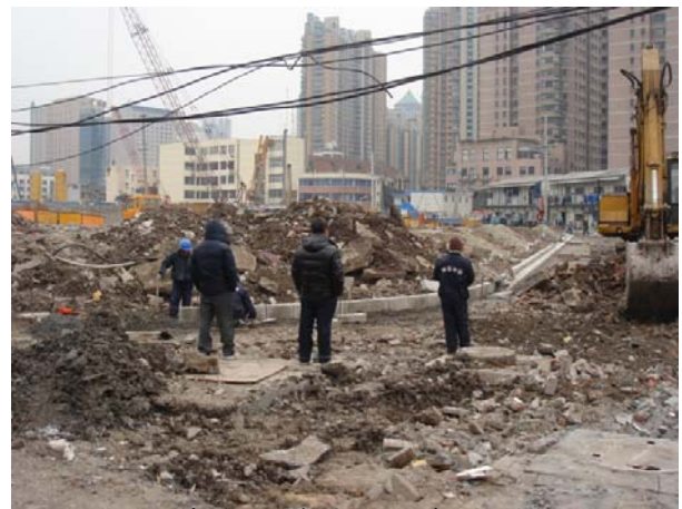
写真-5 上海市内の建設現場
