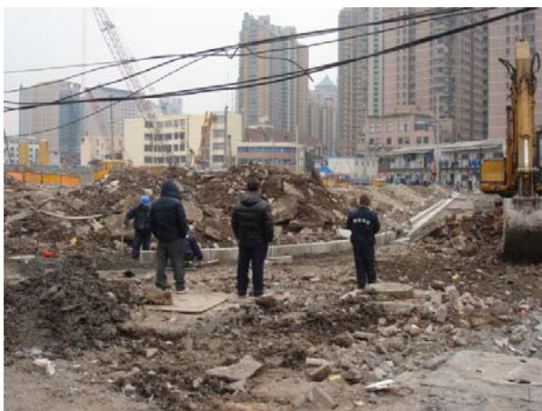
写真-4.4.1.1 工事現場写真
