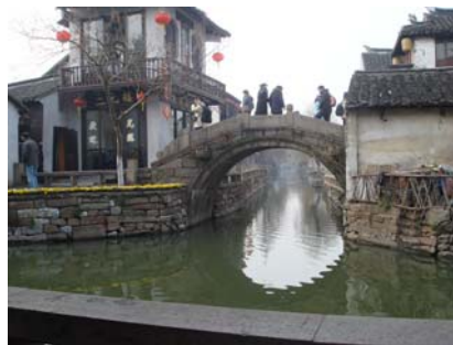
写真 4.4.2-2 明代のアーチ橋
