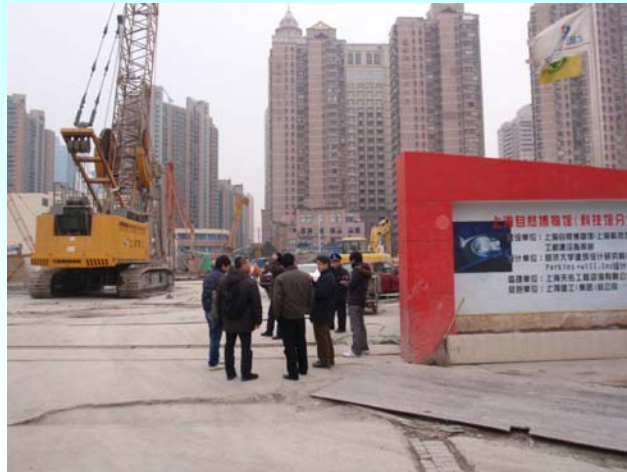
写真-4 上海市内の建設現場
