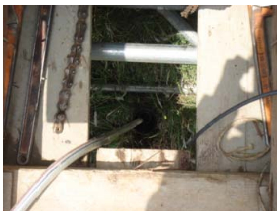
写真-2.2(3).1 透水試験の試験孔
