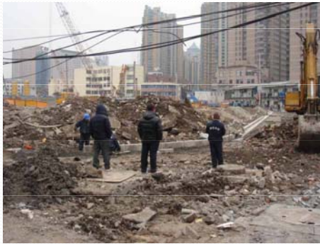
上海市内の建設工事現場
