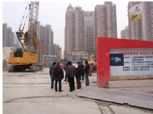
写真-4 上海市の建設現場
