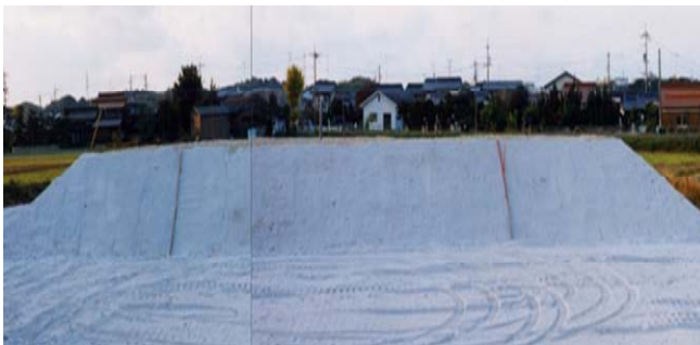
写真-2.2(4)(5).1 現場風景写真
